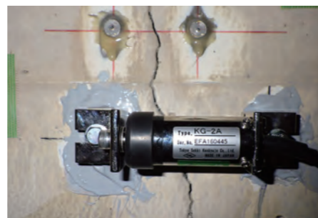
コンクリートひび割れ幅 変位計測
