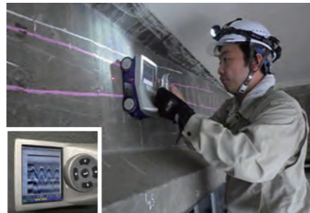
電磁波レーダによる鉄筋探査
