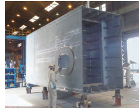
鋼橋工場検査業務
