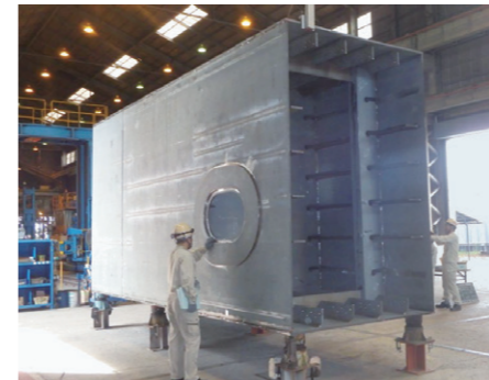
鋼橋工場検査業務
