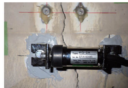
コンクリートひび割れ幅 変位計測
