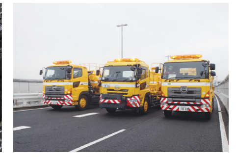
荷重車を用いた載荷による 補強後の安全性確認
