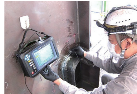
超音波探傷試験(鋼桁切欠き部の溶接部)
