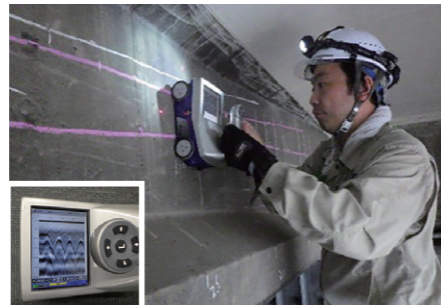
電磁波レーダによる鉄筋探査
